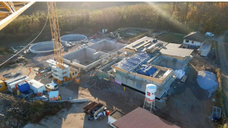
Anfang April 2020 wurde mit den Arbeiten zur Errichtung der neuen Verbandskläranlage in Pulkau begonnen. Die Betonarbeiten für die Bauphase 1 sind größtenteils beendet und mit der maschinellen und elektrotechnischen Ausrüstung wurde bereits begonnen. Bis Mitte Dezember 2020 werden noch die Dachkonstruktion für das Betriebsgebäude fertiggestellt und die Fenster und Türen eingebaut sowie diverse Rohrleitungen verlegt.
