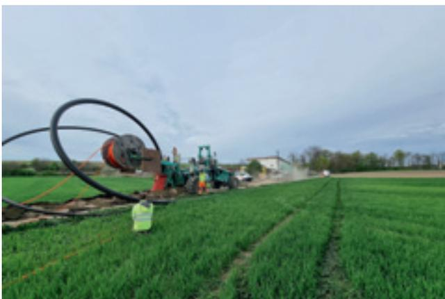
Als größtes Mitverlegeprojekt ist die Strecke zwischen Schrattenthal und Pulkau zu erwähnen, hier wurden auf einer Länge von ca. 3,5 km die Leerrohre mit eingepflügt und alle Gebäude, die sich auf dieser Strecke befinden bereits angeschlossen. Damit sind Pulkau und Schrattenthal die ersten Orte im Retzerland, die miteinander verbunden sind.
